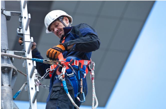
Ein Techniker bei der Arbeit am Fernmeldeturm.
