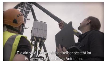
Die aktive Antennen-einheit selber besteht im Prinzip aus 64 kleinen Antennen.
